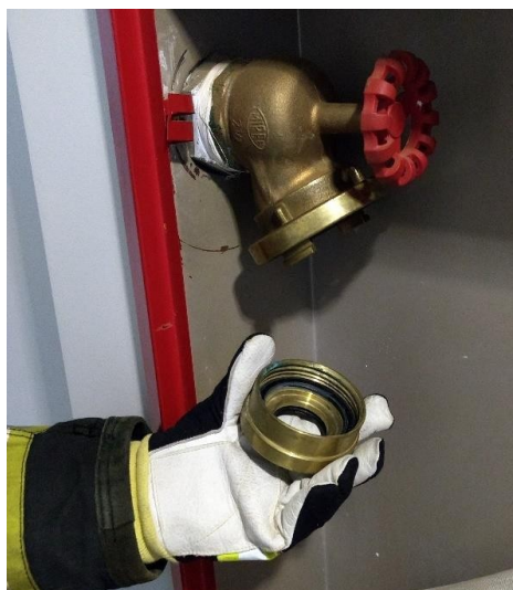
Adaptador de 1. 1/2" sendo substituído por 2. 1/2"
