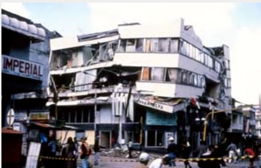
Figura 20 – Exemplo de dano nível severo
