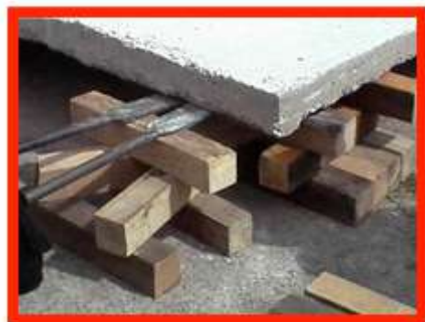
Figura 50 – Demonstração da alavanca – classe 1
