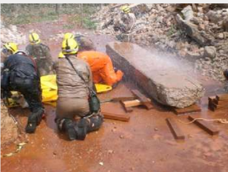
Figura 47 – Exemplo de levantamento de carga
