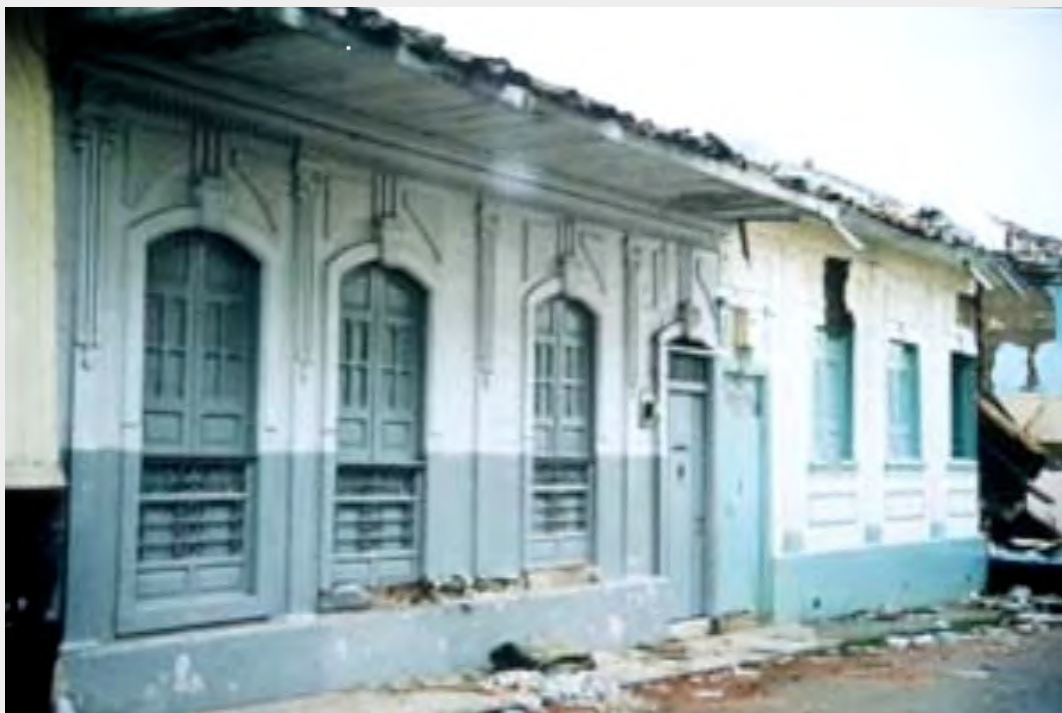
Figura 18 – Exemplo de dano nível leve
