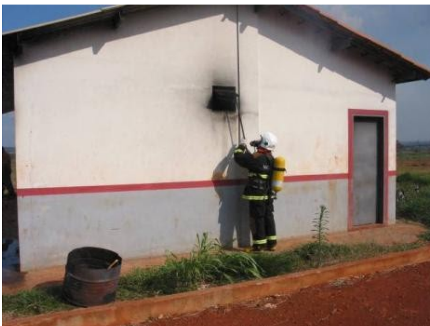
Abertura realizada pelo lado externo
