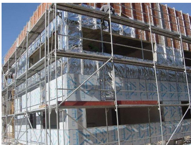
Figura 48 – Exemplo de edificação recebendo re vestimento termo-acústico
