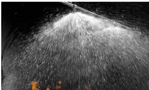
Figura 4: Chuveiro automático descarregando água, formando um cone
