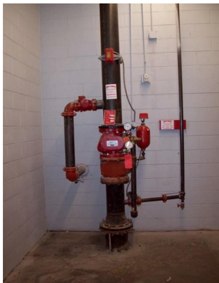
Figura 1: Exemplo de VGA de sistema de tubo molhado
