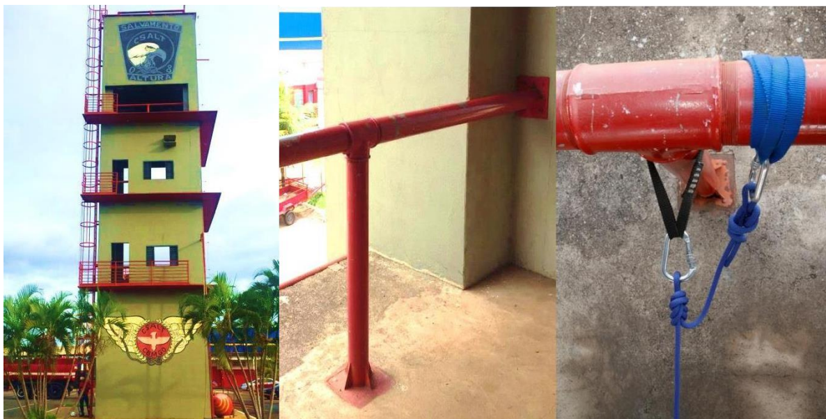
Ponto Estrutural com fixação do anel de fita em Ponto Bomba. Fonte: CBMGO.
