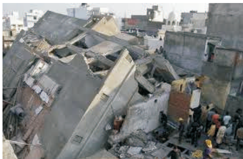
Figura 67 - Local do desabamento
