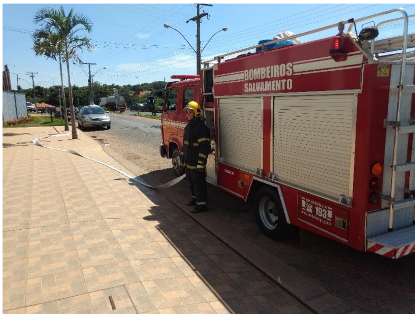
Ligação conectada da VTR ao Hidrante de recalque
