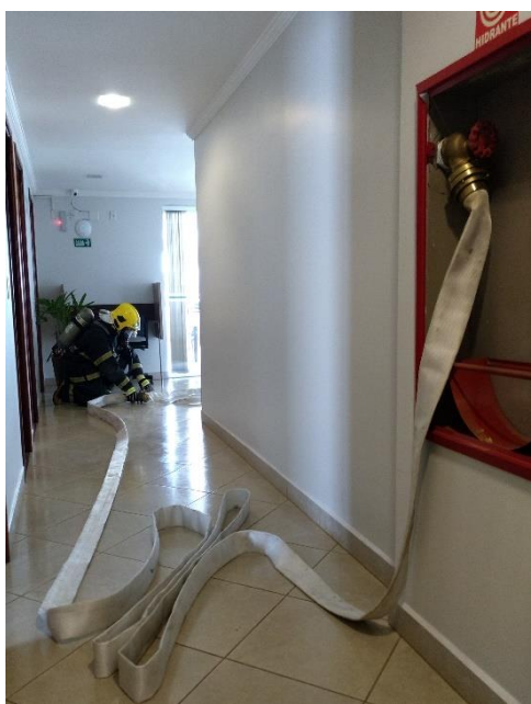
Ligação conectada do hidrante ao divisor
