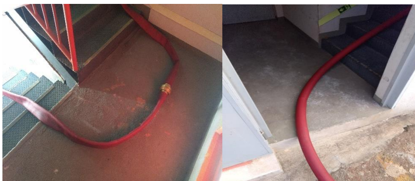
Ligações estabelecidas na parte externa da caixa de escada
