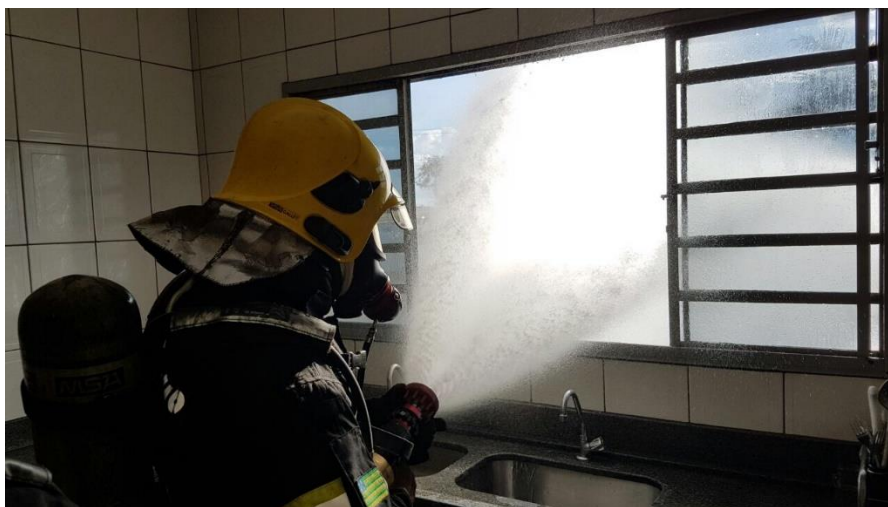
Ventilação por arrastamento hidráulico - Jato d'água saindo completamente pela abertura
