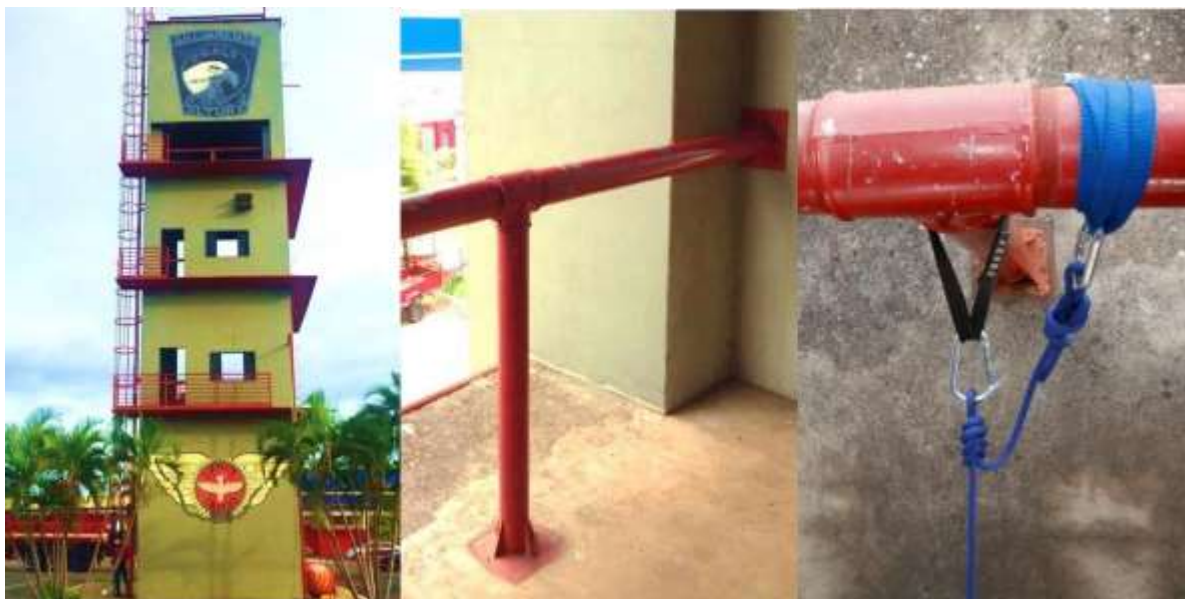
Ponto Estrutural com fixação do anel de fita em Ponto Bomba.
