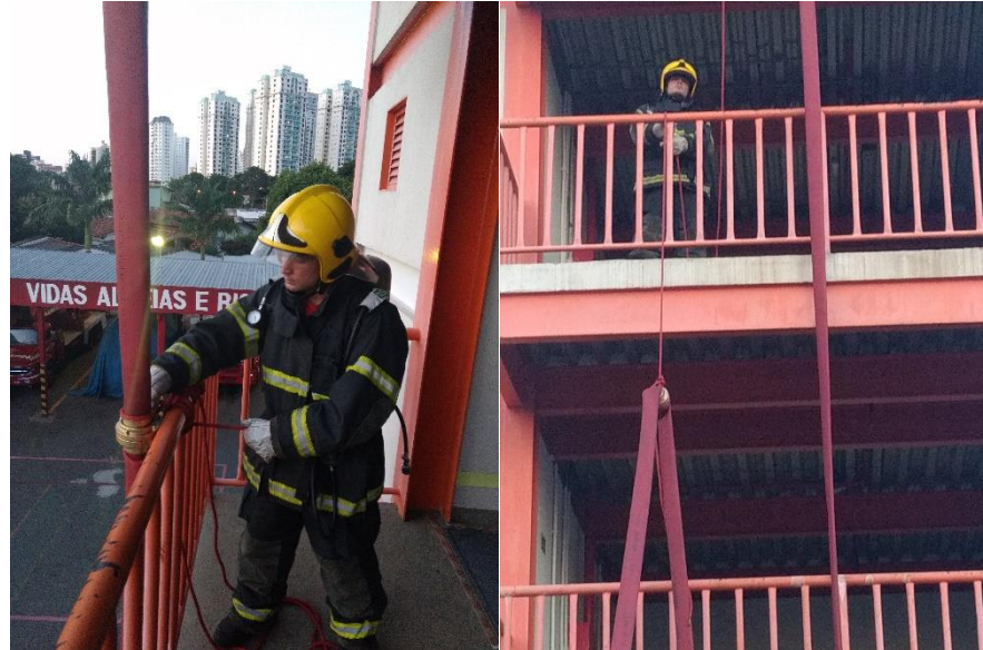
Realizando o içamento e fixação da ligação na fachada
