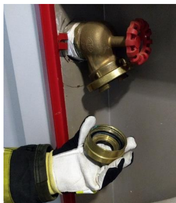
Adaptador de 1. 1/2” sendo substituído por 2. 1/2”
