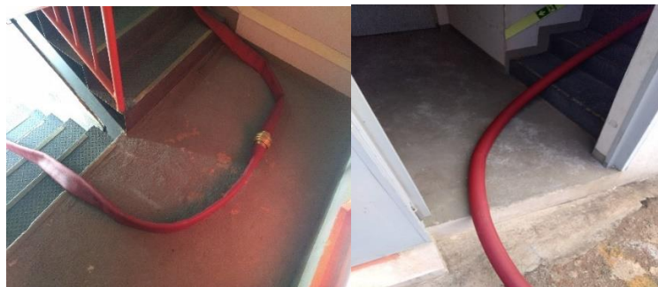
Adutoras estabelecidas na parte externa da caixa de escada
