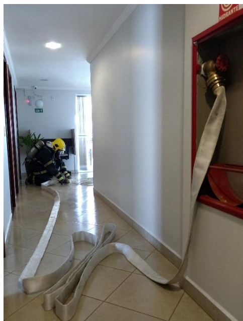
Adutora conectada do hidrante ao divisor
