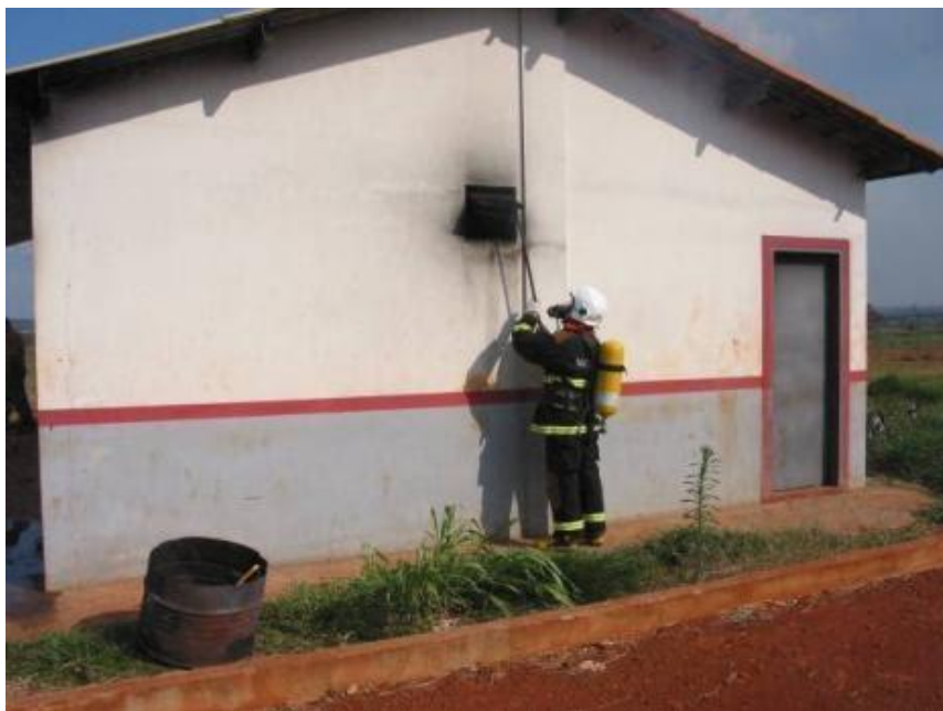
Abertura realizada pelo lado externo
