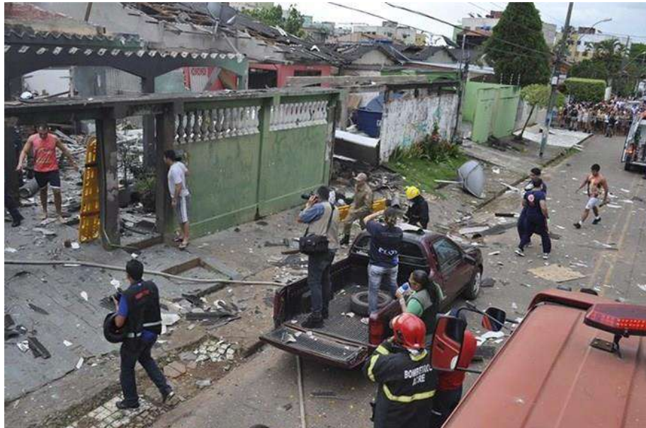
Figura 7: Explosão em uma casa no bairro Manoel Julião.
