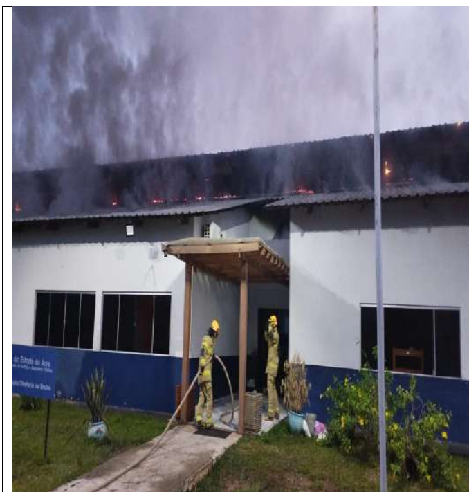
01 – Entrada da edificação
